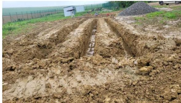
Une tranchée de 70 cm a été réalisée, recouvert sur 50 cm de gravillons 10/20, ensuite la hauteur de drain est de 10 cm, et il a été remis par-dessus 20 cm de terre végétale.
